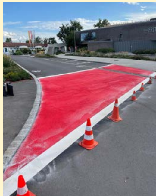
Markierung eines Übergangs mit Plasti Route Rollplast
