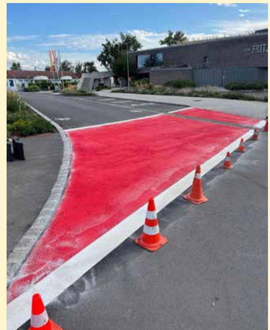
Markierung eines Übergangs mit Plasti Route Rollplast
