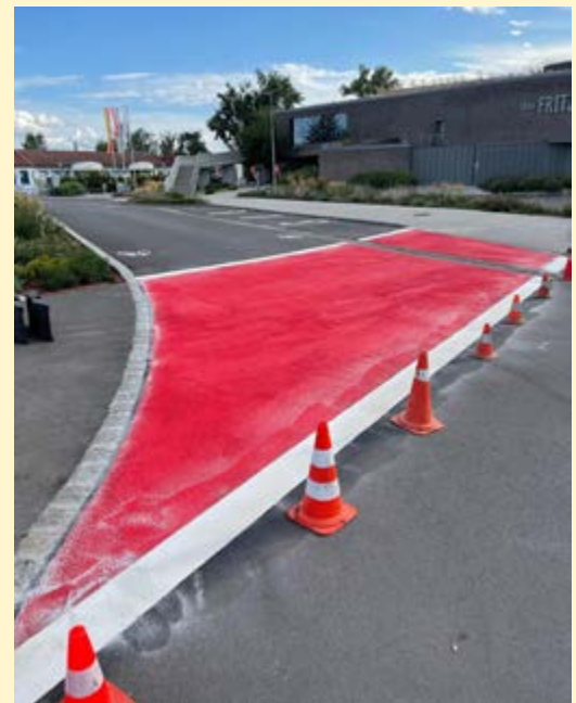
Markierung eines Übergangs mit Plasti Route Rollplast
