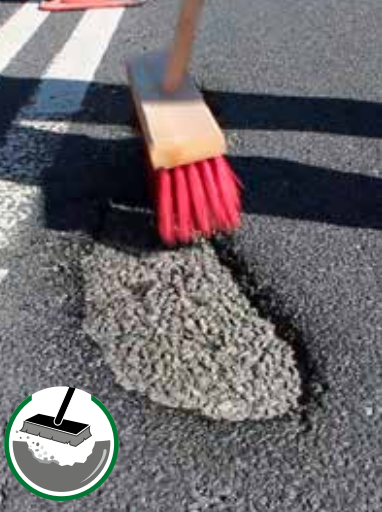
Staub und losen Schmutz im Einsatzbereich gründlich entfernen.
