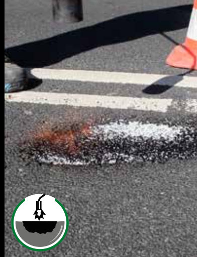
Erhitzen Sie das Material auf ca. 200°C mit dem Gasbrenner.
