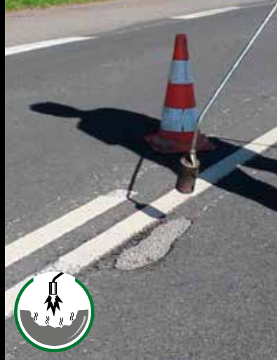
Mit einem Gasbrenner den Einsatzbereich vorheizen.
