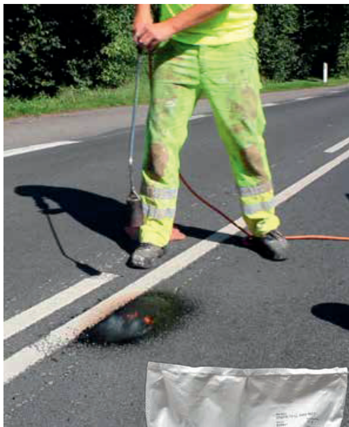
Füllen Sie eine Schicht ChipFill® von maximal 15mm in den Einsatzbereich
