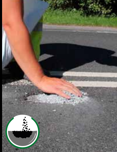
Füllen Sie eine Schicht ChipFill® von maximal 15mm in den Einsatzbereich
