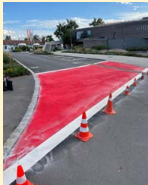
Markierung eines Übergangs mit Plasti Route Rollplast
